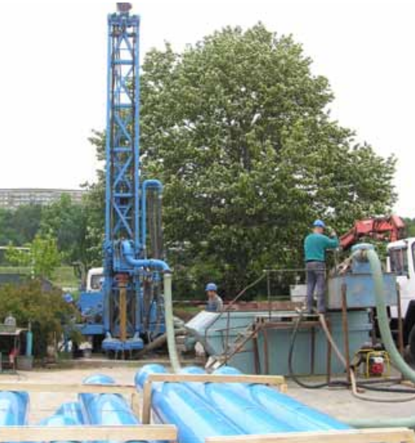
Abb. 3 PVC-Ausbaumaterial vor dem Einbau in ein im Lufthebe-Bohrverfahren abgeteufes Bohrloch
