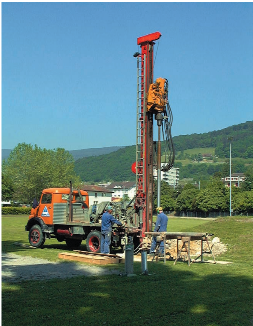
Abb. 3 Kernbohrung zur Entnahme von Aquiferproben in der Oxidationszone
