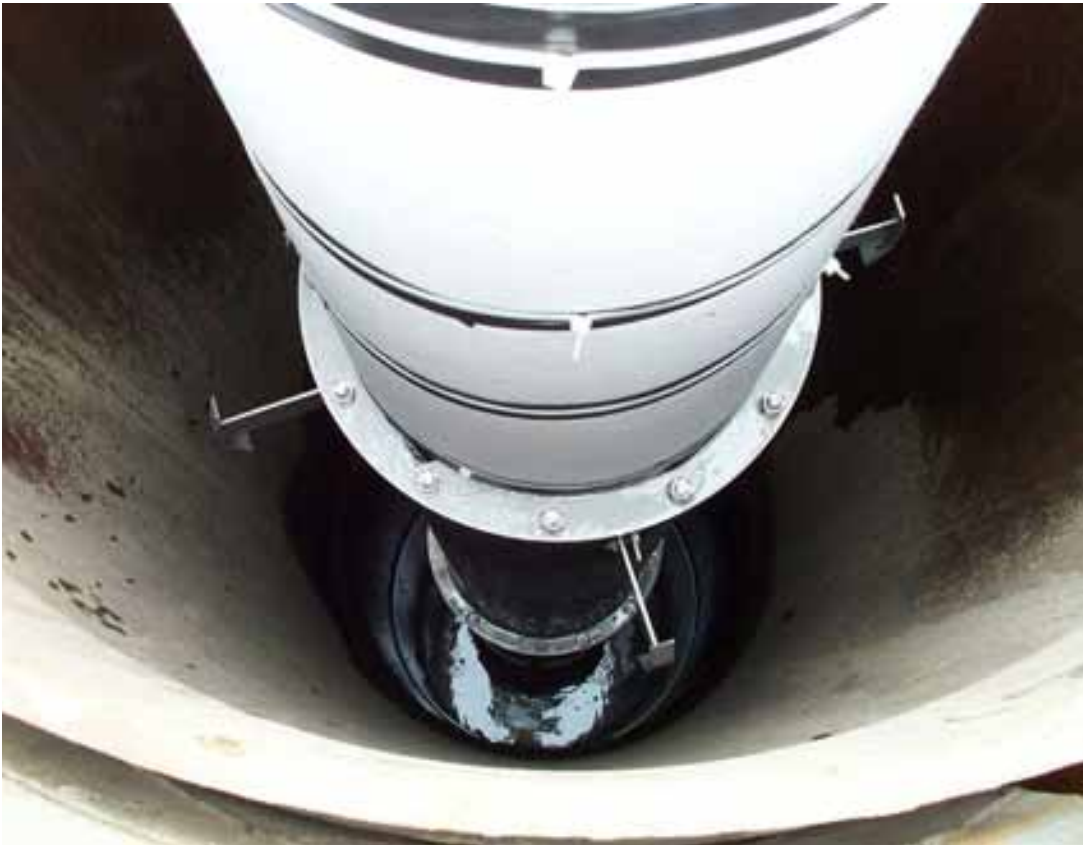
Abb. 1 Einbau der Ausbaurohrung in verrohrte Bohrung: Gut zu sehen sind die Flanschverbindungen und die Abstandshalter.
