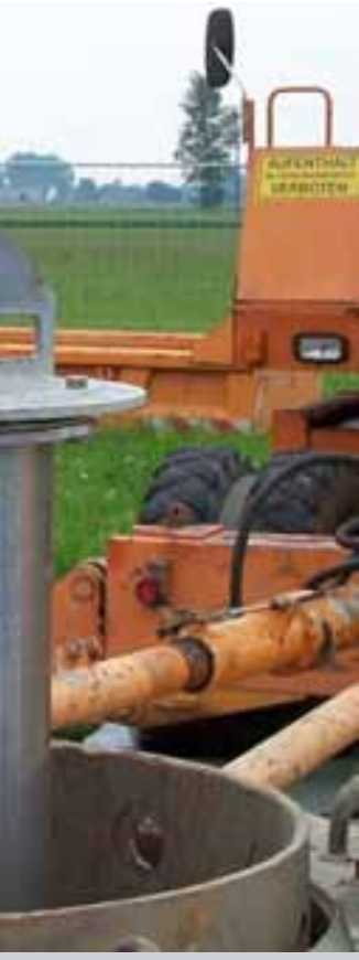
Abb. 4 Einbau von Wickeldrahtfiltern mit Flanschverbindung mittels Hebekappe in Trockenbohrung
