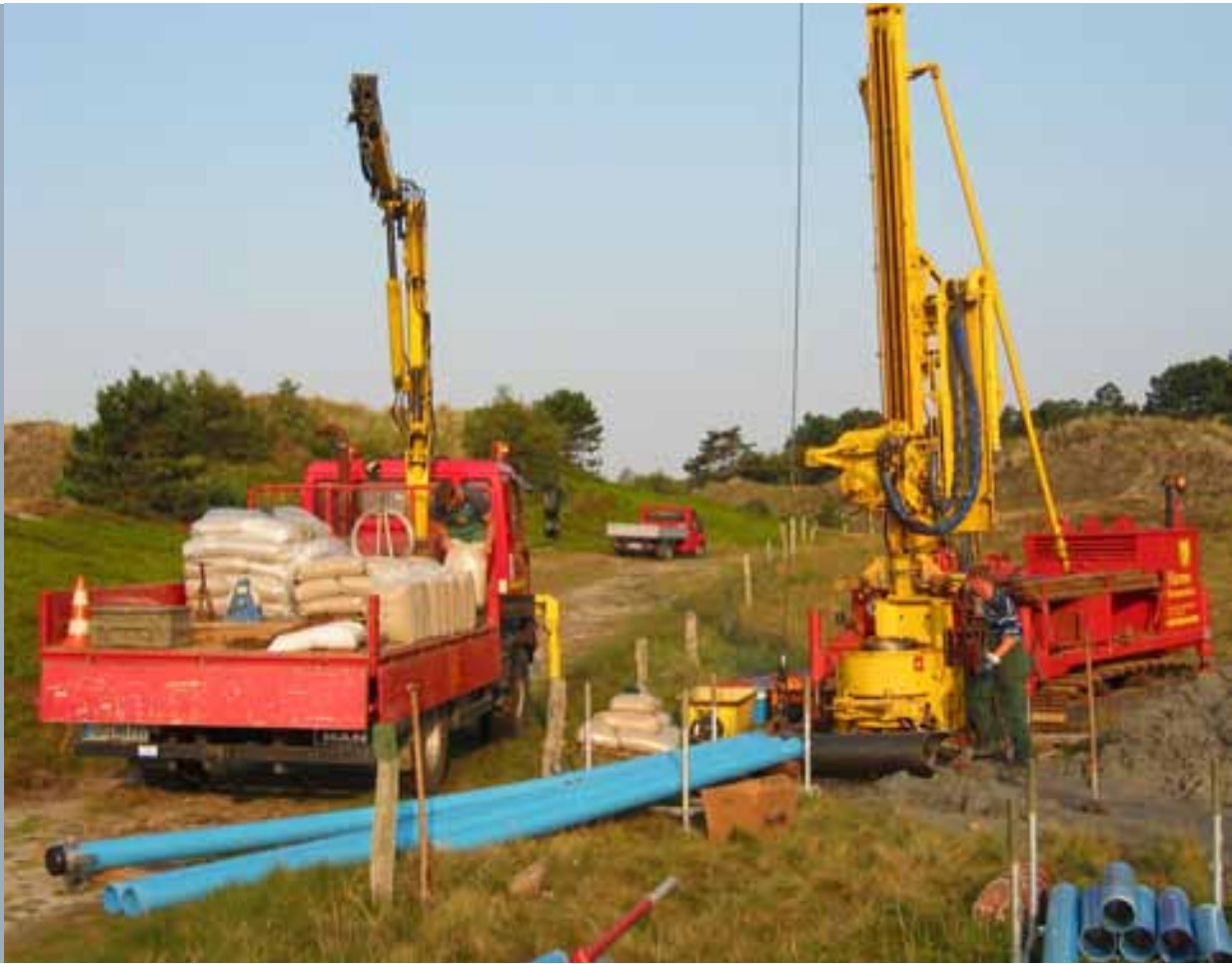
Abb. 7 Brunnenbohrung im Trockenbohrverfahren auf einer Ostfriesischen Insel
